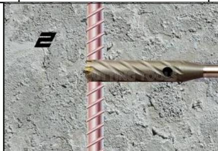
使用相同直徑的鋼筋切斷器切至**旋轉模式**切斷鋼筋
